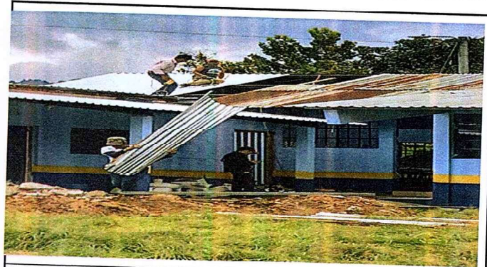
Foto 4: Sustitución de Láminas
