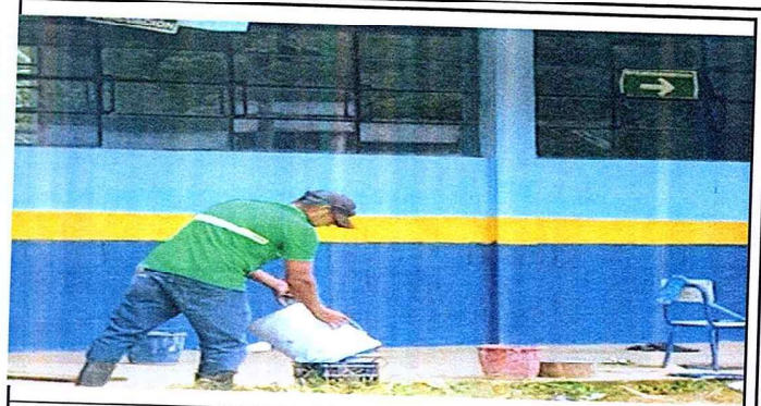
Foto 2: Pintura interior y exterior de escuela
