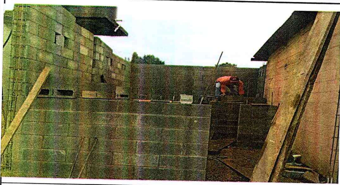
Foto 1: Construcción de Baños
